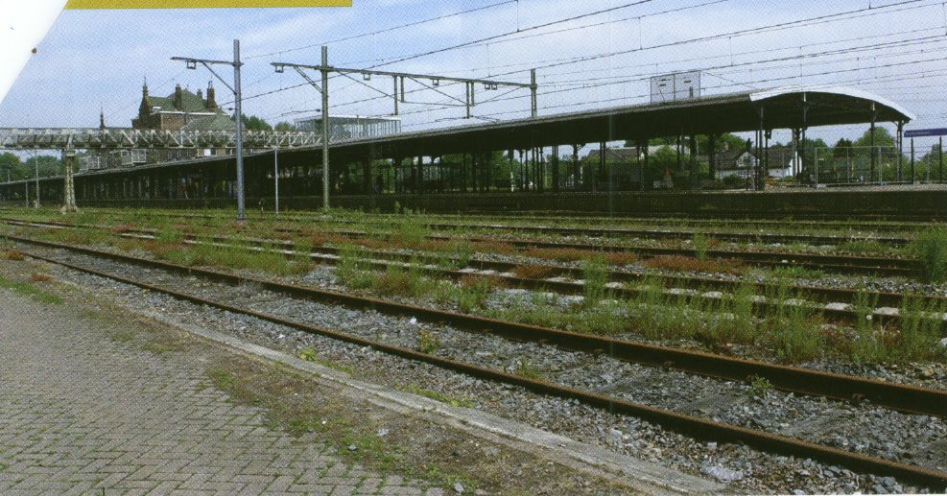
Station Geldermalsen met de lange en unieke perronoverkapping van golfplaat.
