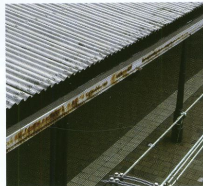
Golfplaten op de perronoverkapping vanaf de oorsprong.
