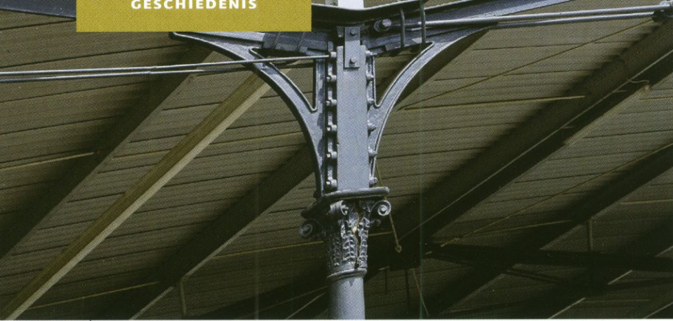
De oorspronkelijke gietijzeren kolommen werden rond 1962 opgehoogd.
